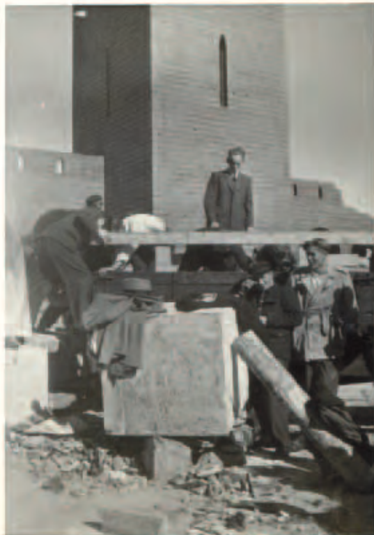
Fotografie – dokumentacja rozbiórki mauzoleum Paula von Hindenburga pod Olsztynkiem w 1949 roku autor nieznany papier fotograficzny sygn. DH 2462–2464 OMO
