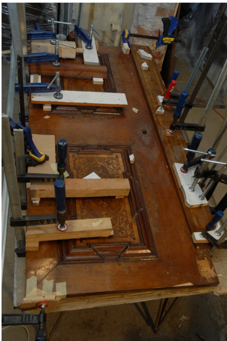
Podklejanie luźnych elementów intarsji i okleiny.
