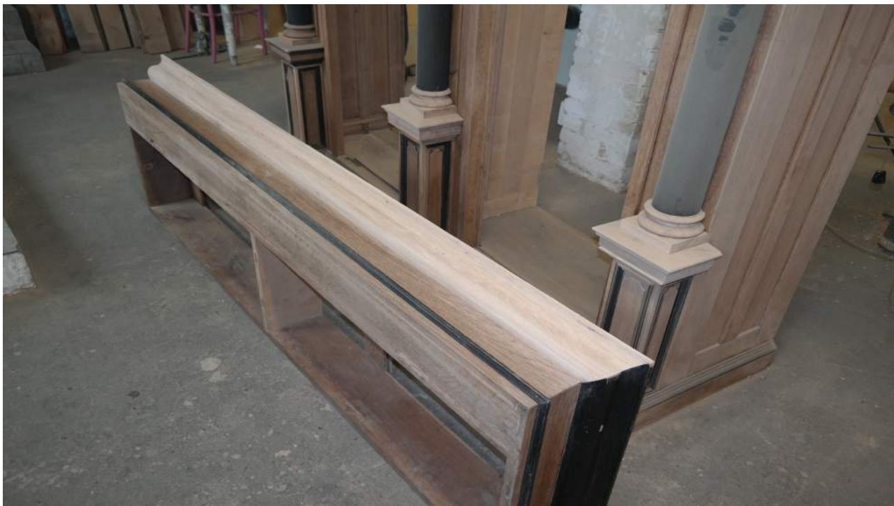
Zdjęcia odtworzonego fragmentu gzymsu szafy Mb-253-OMO
