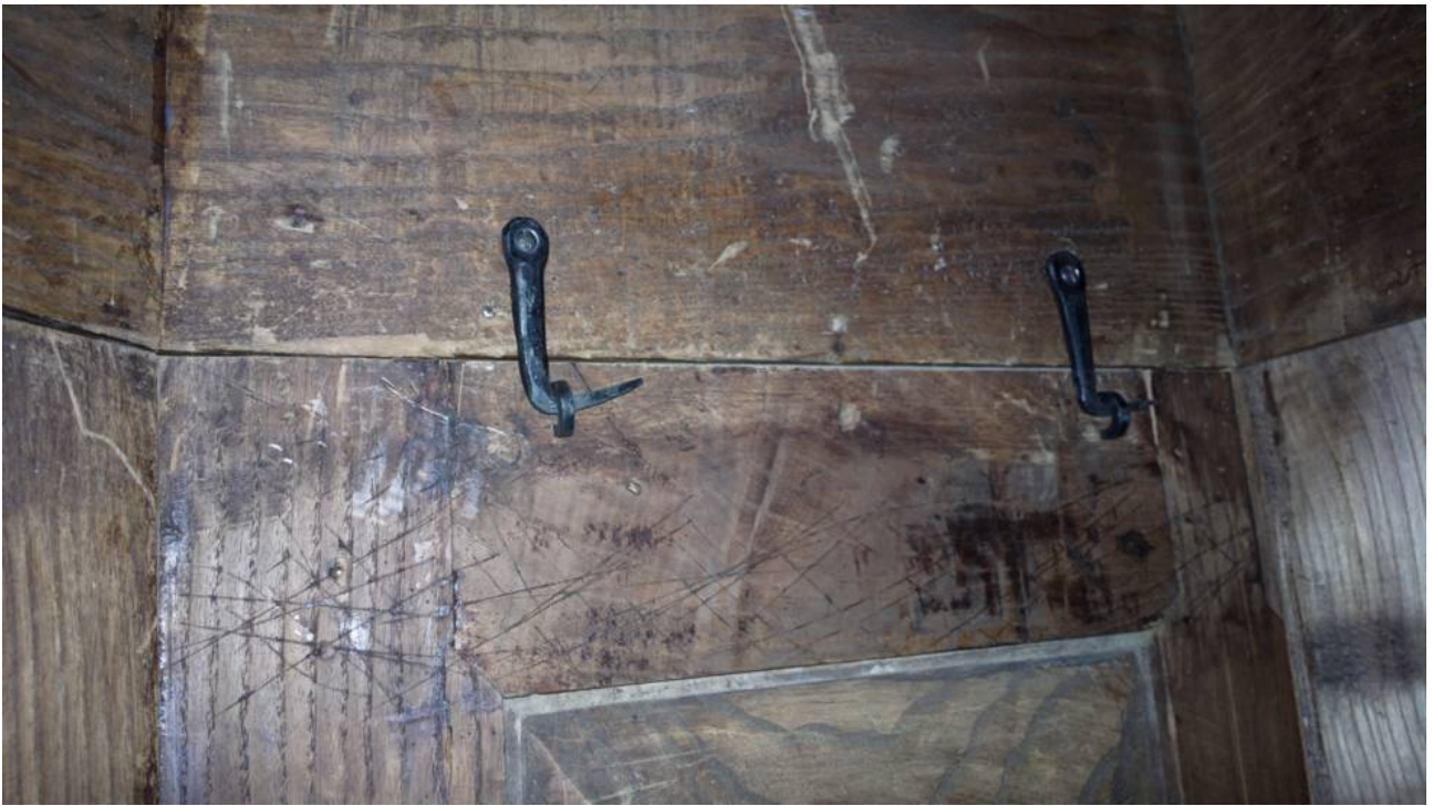
Zrekonstruowane haki spinające wieniec górny i bok szafy .
