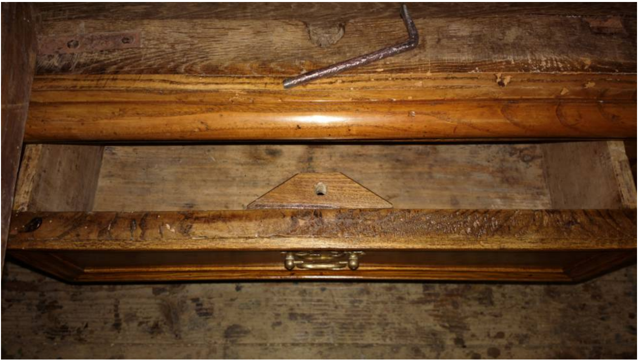
Uchylona lewa szuflada , ze zrekonstruowaną drewnianą blokadą i stalowym rygłem .
