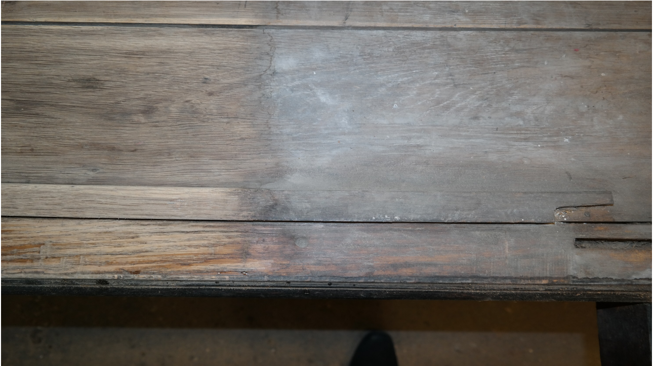
Zdjęcie w trakcie mycia powierzchni szafy Mb-253-OMO
