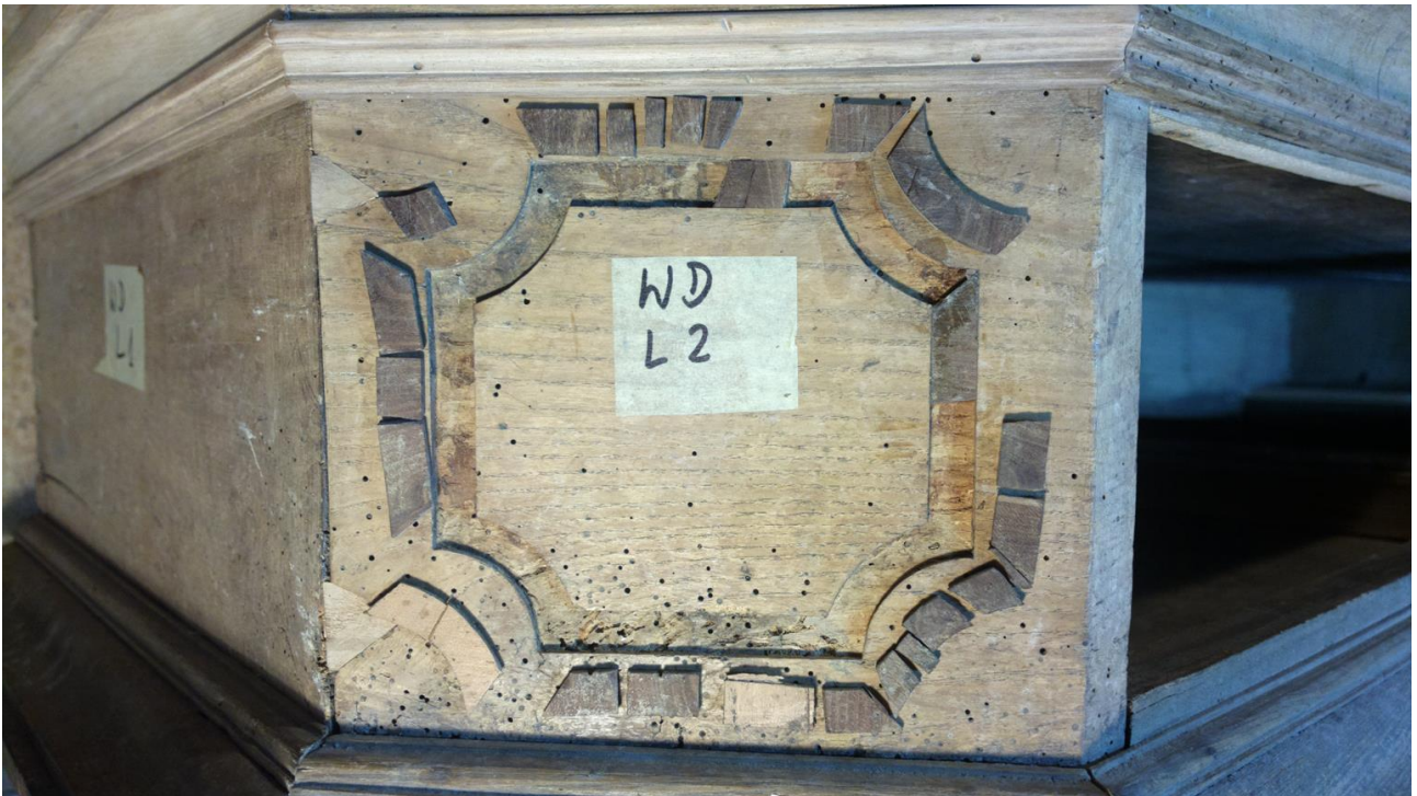
Lewy element cokołu , z wyjętą wstęgą intarsji .
