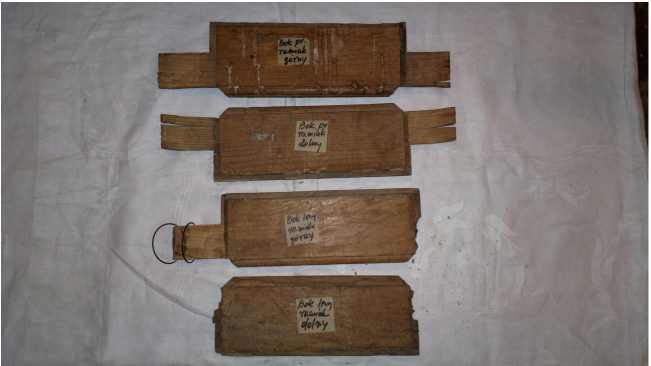
Ramiaki ścian bocznych przed naprawą .
