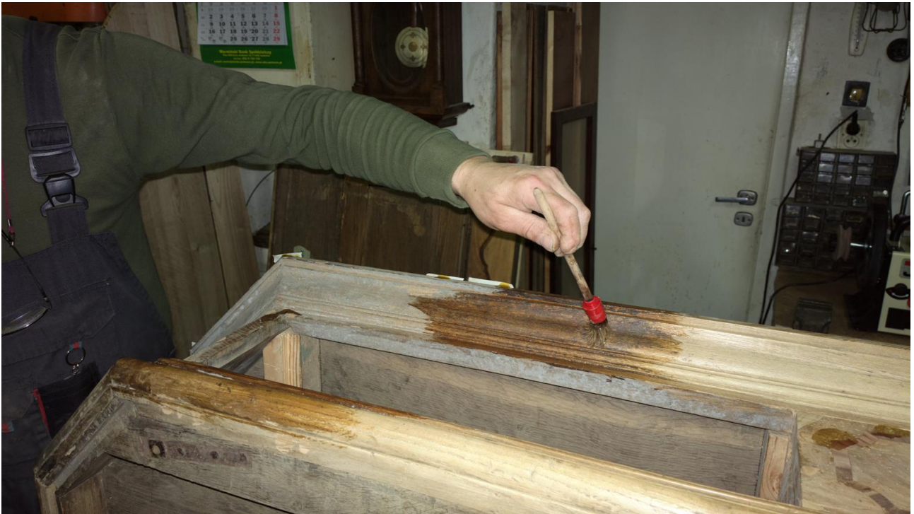
Nakładanie preparatu Remosol , w celu zmiękczenia starej polityry .
