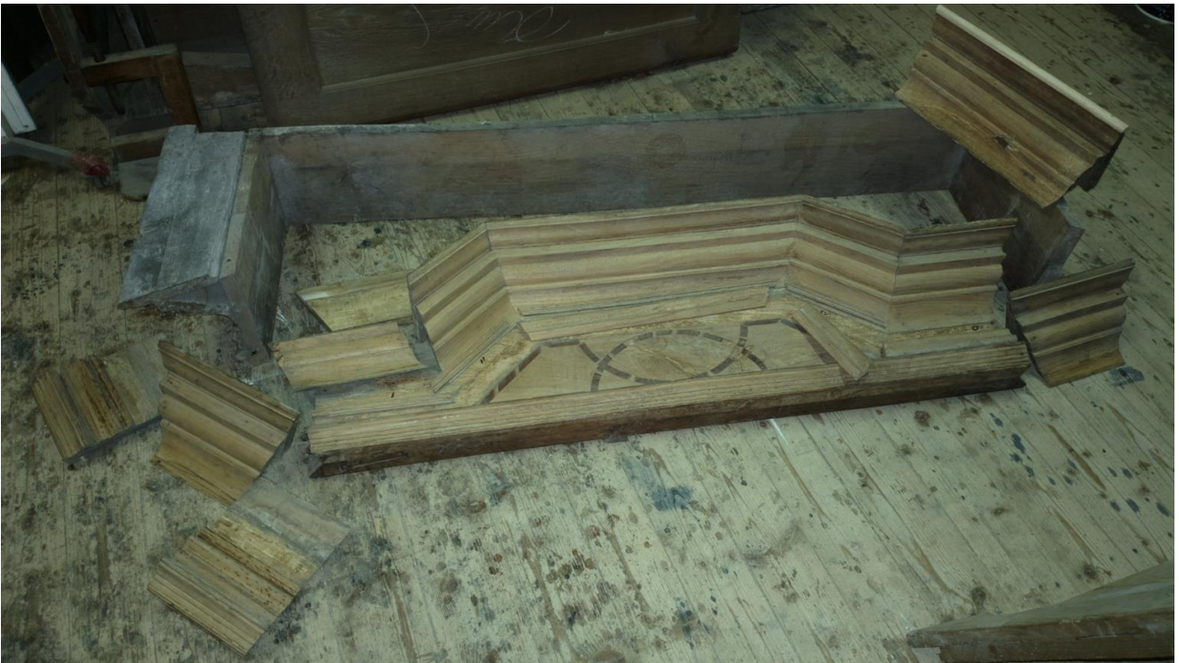
Po wyjęciu starych, zardzewiałych gwoździ wieńiec dał się łatwo rozebrać.
