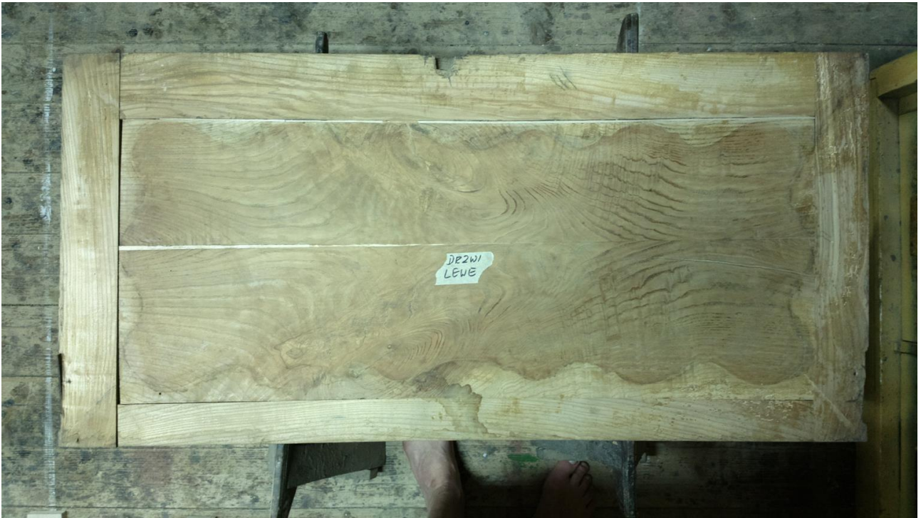
Płyta drzwi lewych, z zaflekowanymi pęknięciami.
