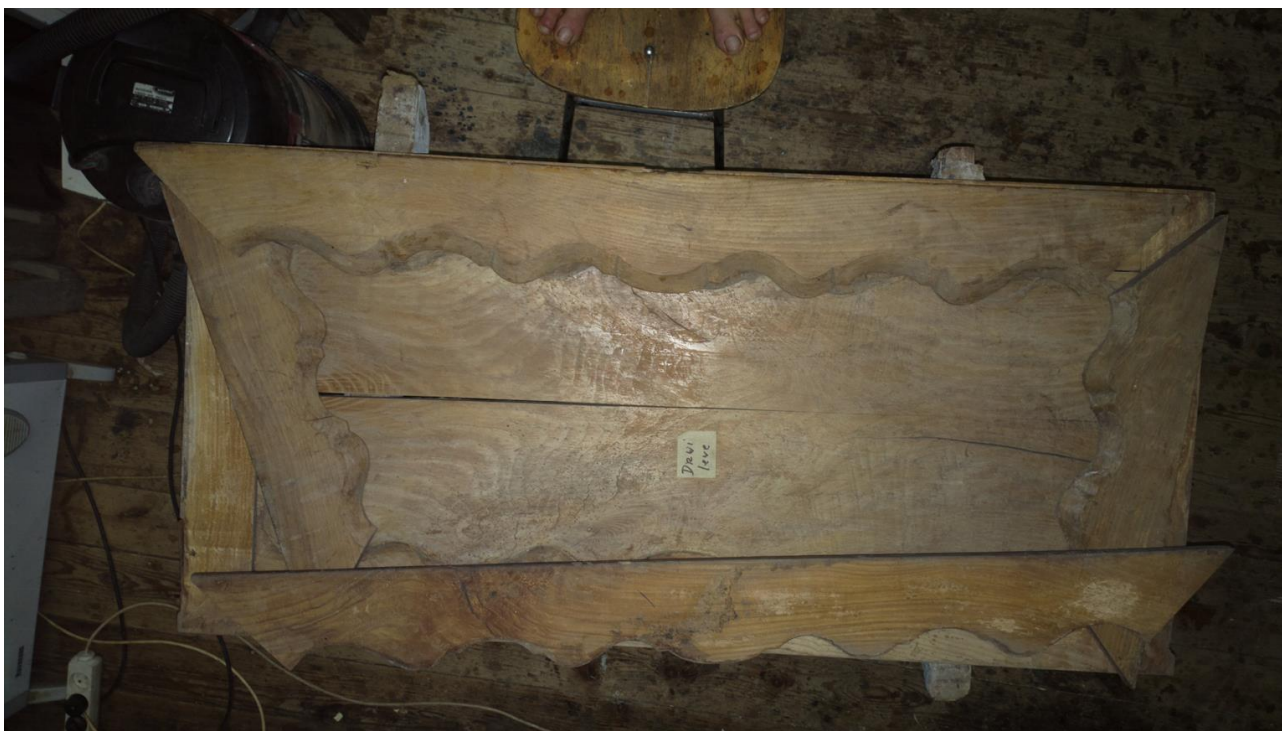
Drzwi lewe z odklejonymi ramiakami.
