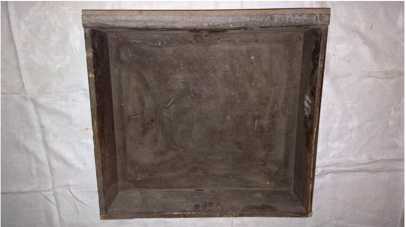
Wnętrze szuflady było pokryte ciemną, bardzo twardą, niezidentyfikowaną substancją.
