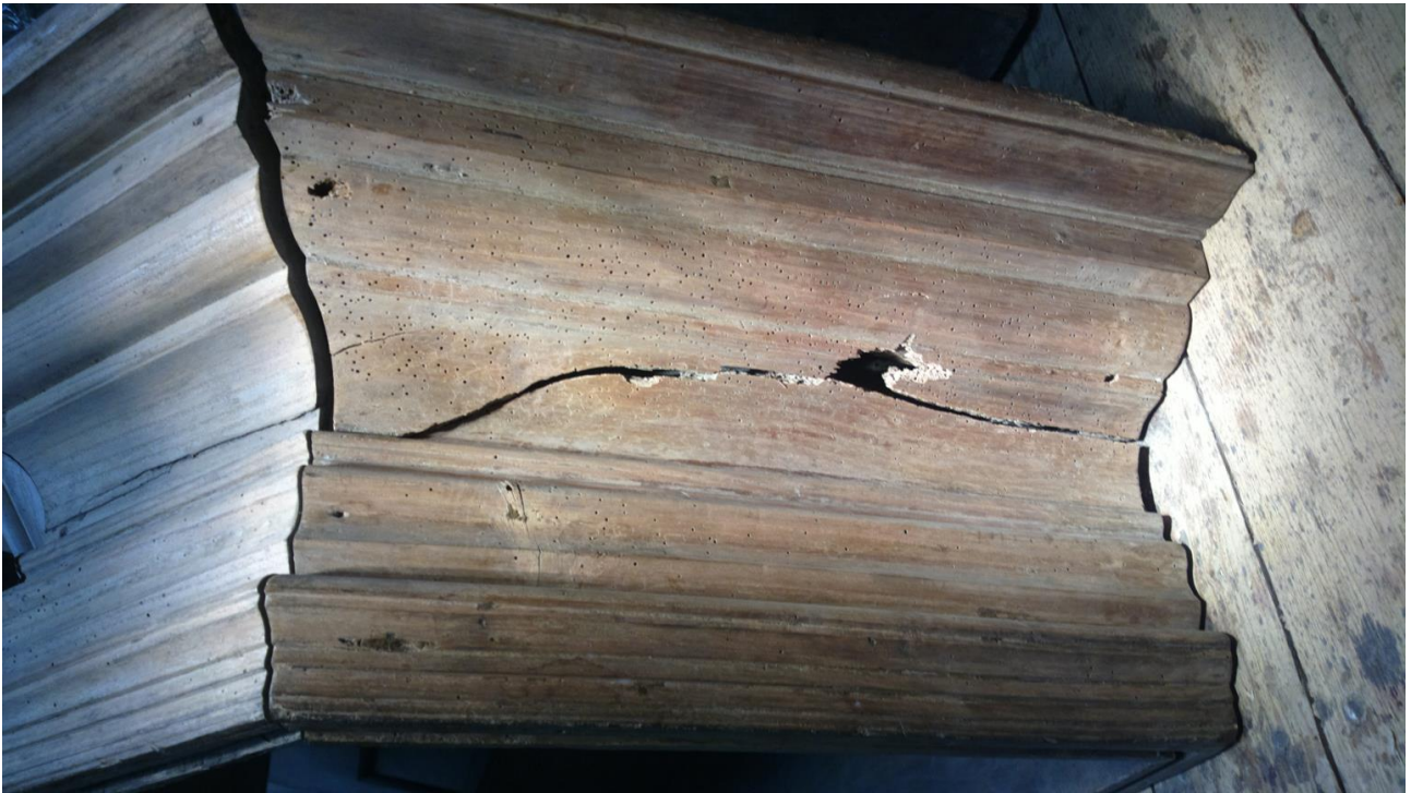
Bok wieńca przed naprawą.
