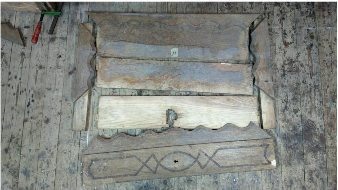
Drzwi prawe, po rozklejeniu.
