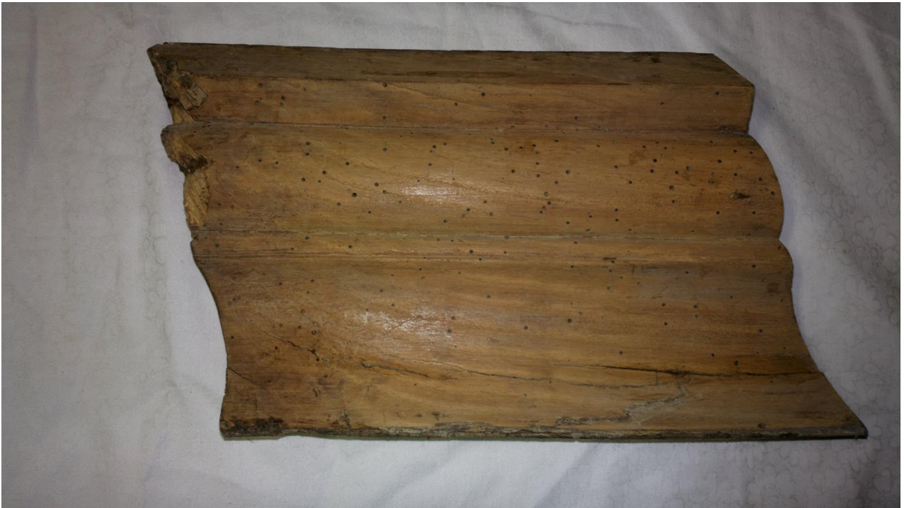
Element wieńca górnego przed naprawą.
