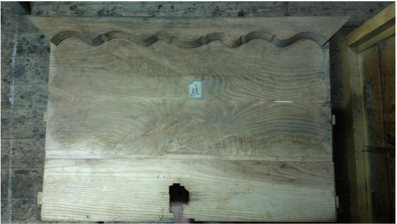
Płyta drzwi prawych, po sklejeniu.
