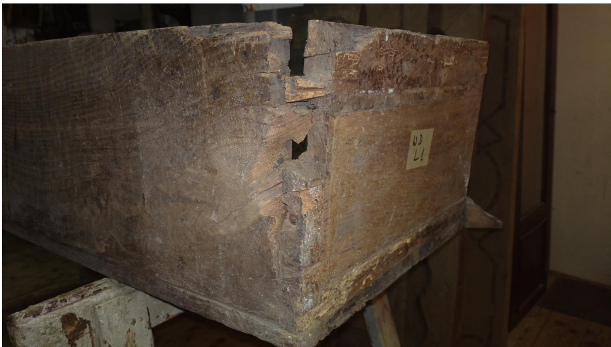
Lewy, tylny narożnik skrzyni cokołu zniszczony przez owady z dużymi ubytkami drewna.
